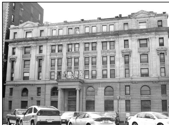
Fig.2 Prima clădire civilă cu structură de beton armat în S.U.A. (Buffalo, New York), 1894-1897. Proiectanți, arh. Carlton T. Strong (1862-1931) și ing. Ernest Ransome (1852-1917). Sursa foto [15].
