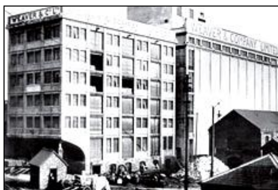
Fig.3 Prima clădire civilă cu structură de beton armat în Marea Britanie (Swansea, Țara Galilor), 1897. Proiectant, ing. François Hennebique (1842-1921). Sursa foto [17].
