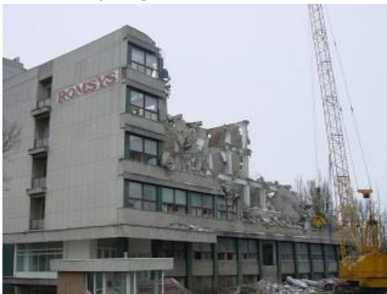
Fig. II.18 Momentul demolării Institutului de Cercetări și Proiectări Electronice
