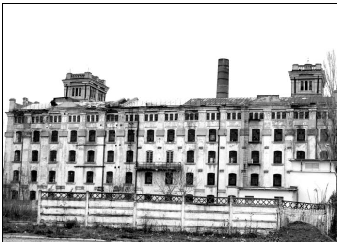
Fig. 5. Silozul de cereale de la Brăila (1884-1888). Este prima construcție din România și primul siloz din Europa la care este utilizat betonul armat. Este construcția la care se aplică în premieră la nivel mondial prefabricarea la sol a pereților de beton armat ai celulelor silozului și sistemul de armături sudate la montaj.
