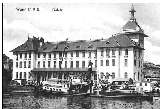
Fig.4 Prima clădire civilă cu structură de beton armat în România (Galați), 1910-1911. Proiectanți, arh. Petre Antonescu (1873-1965), ing. Ioan Vardala (1872-1950) și ing. Vasile Roșu.
