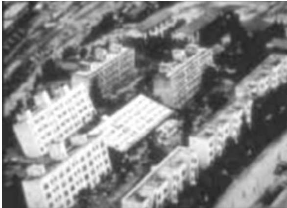
Fig. II.2.2. Lichefiere și tasări diferențiate în Niigata (fotografie realizată de National Geophysical Data Center ).
