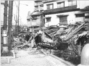
Fig. III.1. Clădiri prăbușite în Kobe (după un raport de J.P. Bardet et al. ( Gifu Univ. ) la USC, cu privire la cutremurul din Kobe, 1995)
