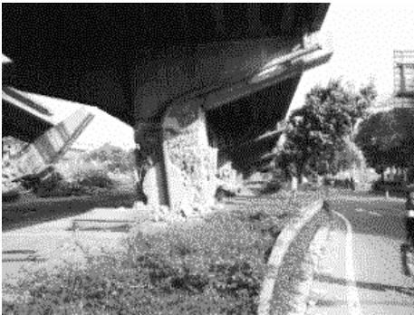
Fig. III.2. Autostradă suspendată, prăbușită în Kobe (după un raport de J.P. Bardet et al. ( Gifu Univ. ) la USC, cu privire la cutremurul din Kobe, 1995).
