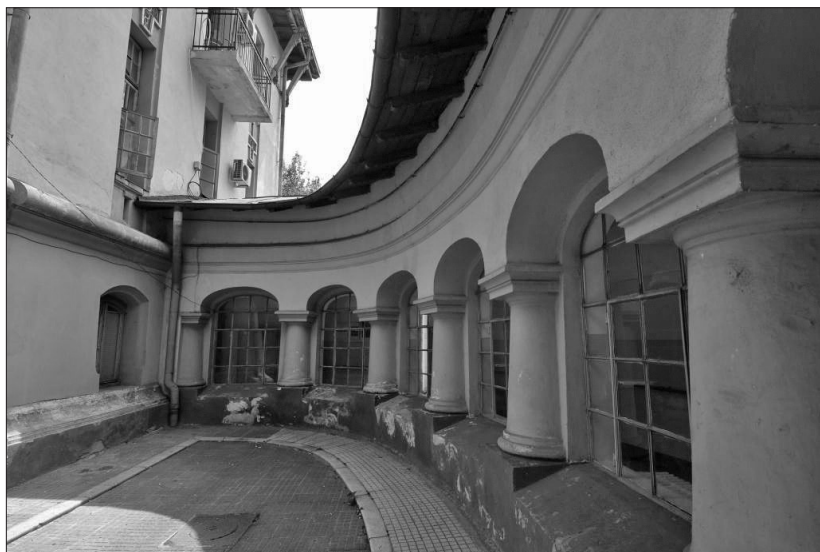
Fig. nr. 4. Legătura între corpul principal și corpul bucătăriei creează o curte interioară.
