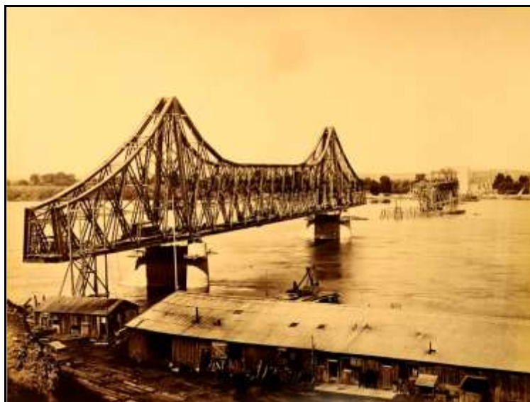
Fig.13. Finalizarea execuției primei grinzi cu zăbrele în consolă, către Cernavodă. Pentru cea de-a doua grindă cu zăbrele în consolă, către viaduct, sistemul de schele susținut de piloți de lemn introduși sub cota fundului albiei fluviului este finalizat și se lucrează la montajul tablierului.
