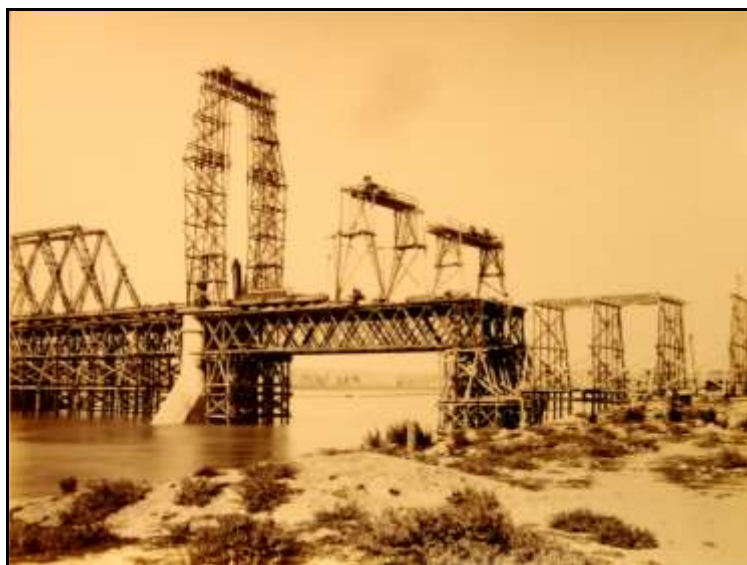
Fig.12. Execuția primei grinzi cu zăbrele în consolă, dinspre Cernavodă. Sistemul de schele este susținut de un grup de piloți de lemn introduși sub cota fundului albiei fluviului. Se lucrează la montajul tablierului.
