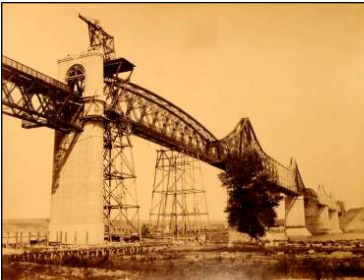
Fig.15. Finalizarea montajului tablierului grinzii cu zăbrele semiparabolice marginale către viaductul Iezer și poziționarea acestuia la cota finală.
