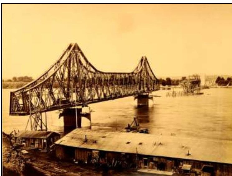
Fig.13. Finalizarea execuției primei grinzi cu zăbrele în consolă, către Cernavodă. Pentru cea de-a doua grindă cu zăbrele în consolă, către viaduct, sistemul de schele susținut de piloți de lemn introduși sub cota fundului albiei fluviului este finalizat și se lucrează la montajul tablierului.
