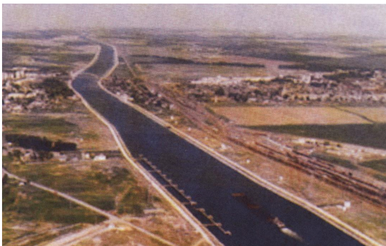
Fig. nr. 2 - Vedere aeriană a Canalului Dunăre-Marea Neagră
